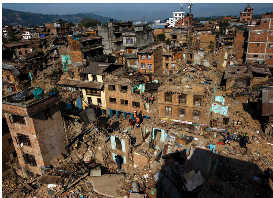
Imagem da destruição provocada por sismo no Nepal, a 25 de abril de 2015
