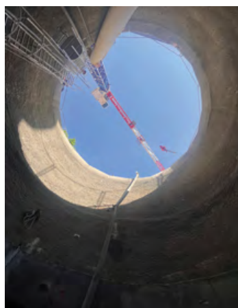
Poço vórtice Av. Liberdade
