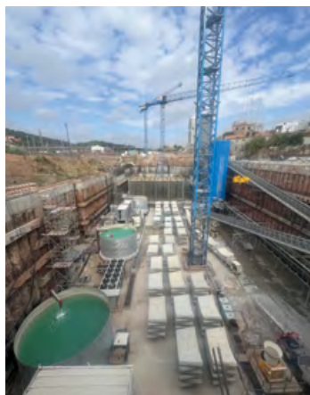
Desvio de Caudal do Caneiro de Alcântara para a Bacia
