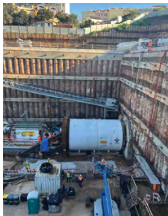
Preparação da Estrutura de reação e escudo alinhado com o emboque
